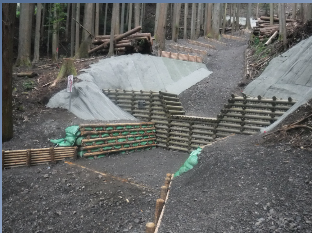
環境に配慮した資材を利用した堰堤工事(静岡市葵区落合地区)
